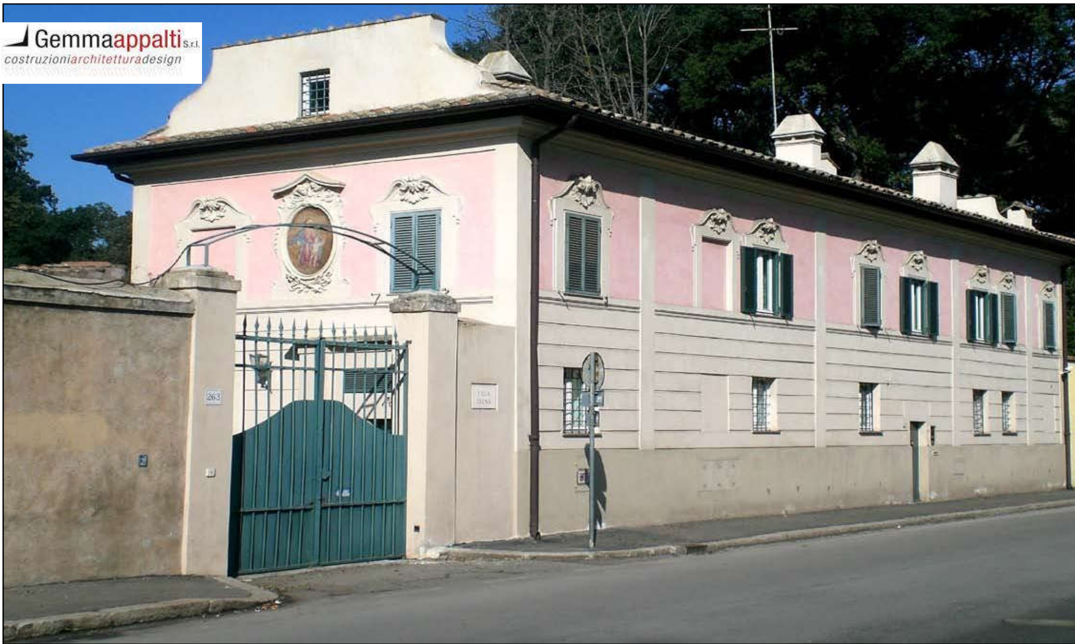
Palazzina del '700 Via Salaria, 263/265 - Roma Opere realizzate nel 2002 con la supervisione della Soprintendenza delle Belle Arti
