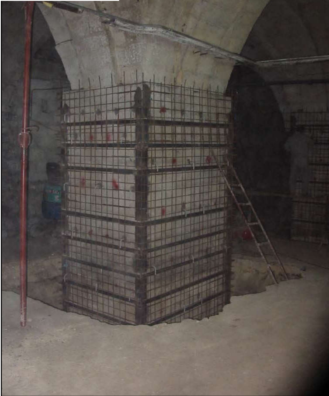
Palazzo dell'800 C.so d'Italia, 11 - Roma Consolidamento e rinforzo strutturale piloni di fondazione. 2004
